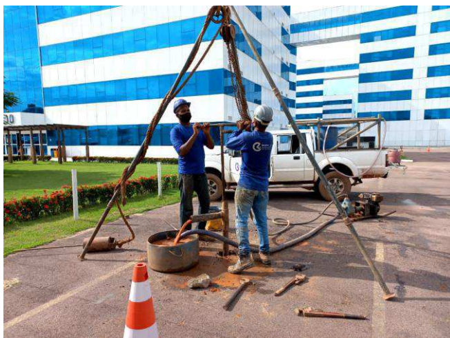
Foto 3 - Sondagem pelo processo de lavagem
