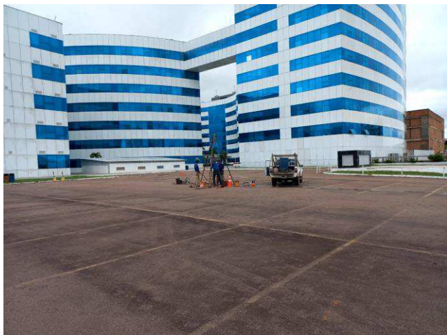
Foto 1 - Vista parcial da área (equipe trabalhando)
